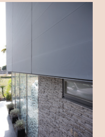
自社ビルの外壁にはニチハのサイディングを含め3つの素材を組み合わせて設計
