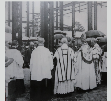
夙川カトリック教会・鉄骨建て方
