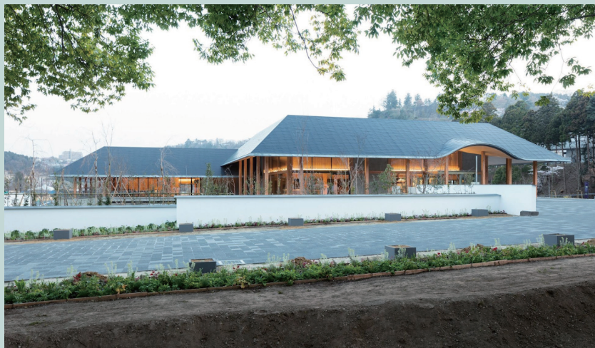
宮城県仙台市に生まれた 『仙臺緑彩館』外観
